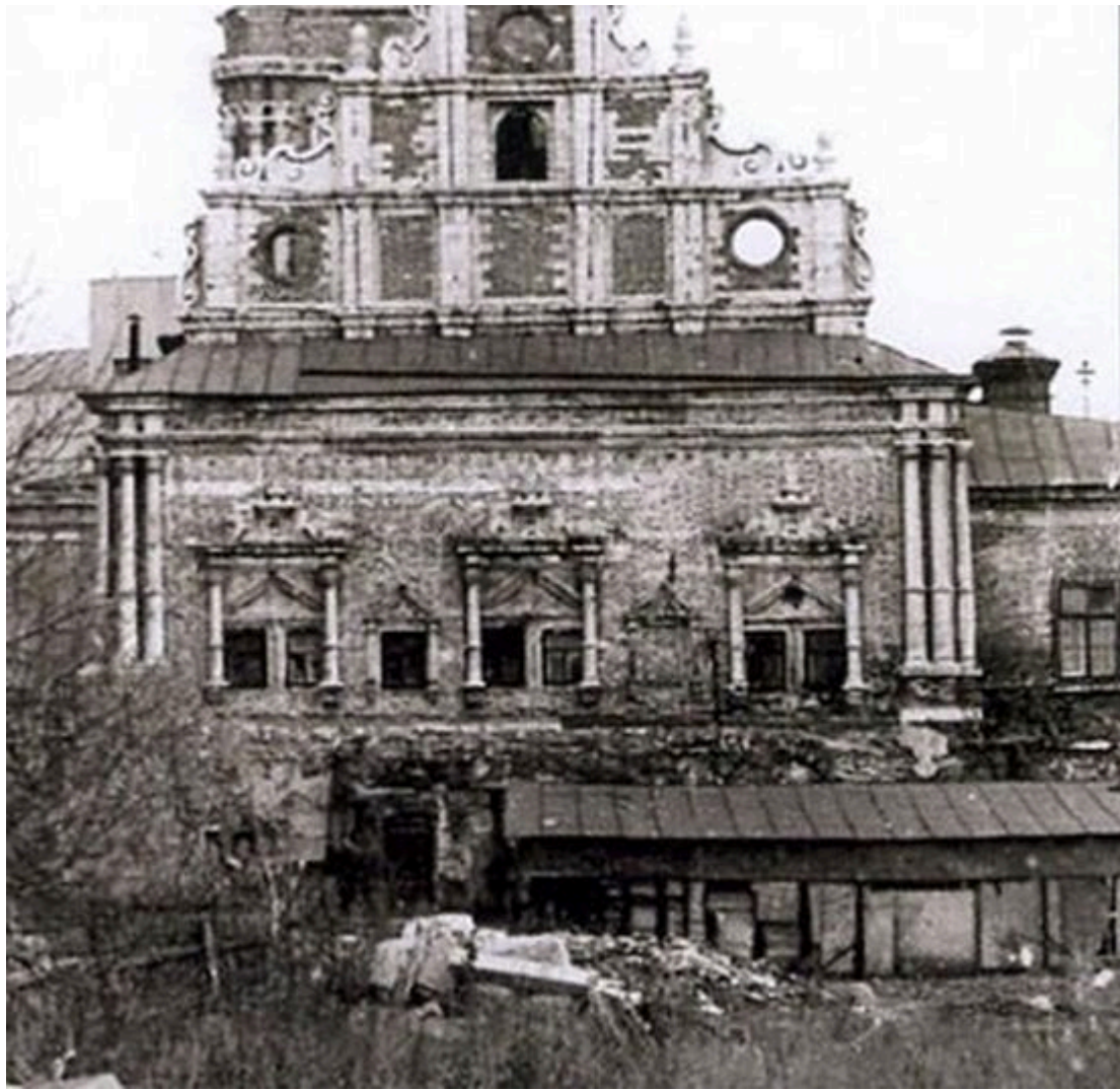
Тихвинский храм разрушенный
